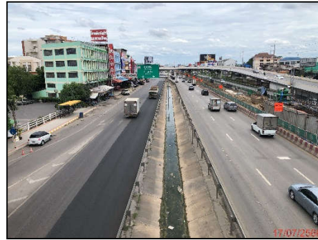
รางระบายน้ำที่เกาะแบ่งช่องทางหลักกับทางขนาน (SEPARATOR) ก่อสร้างแล้วเสร็จ กม.27+800 (ซ้ายทาง)
