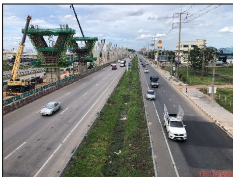
รางระบายน้ำที่เกาะแบ่งช่องทางหลักกับทางขนาน (SEPARATOR) ก่อสร้างแล้วเสร็จ กม.34+900 (ขวาทาง)
