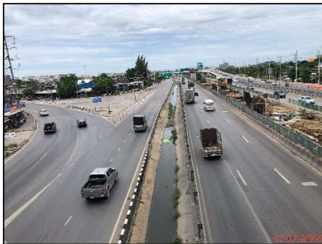
รางระบายน้ำที่เกาะแบ่งช่องทางหลักกับทางขนาน (SEPARATOR) ก่อสร้างแล้วเสร็จ กม.28+000 (ขวาทาง)
